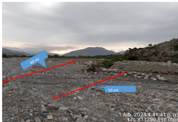
FIGURA N°02: CAUCE DEL RIO LOCO EN EL SECTOR HUARCOS, ANCHO DE CAUCE 40 ML Y ANCHO DE CAUCE AGUAS ARRIBA 10 ML.
